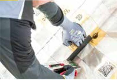
Die Klimamembran wird mit der Vario® ZSL Sanierungsleisten in der unteren Ecken durch antackern fixiert. Dies verhindert das einströmen von warmer Raumluft zwischen Klimamembran und Sparren bis oben an die kalte Sparrenoberkante. Leistenabstand etwa 30 cm. (2 Stck/lfdm). Bei offener Innenbekleidung z.B. Nut- und Federbretter werden die Sanierungsleisten durchgängig verlegt, hierbei im Überlappungsbereich der Bahnen die Vario® ZSL erst nach der Verklebung der Klimamembran ergänzen.
