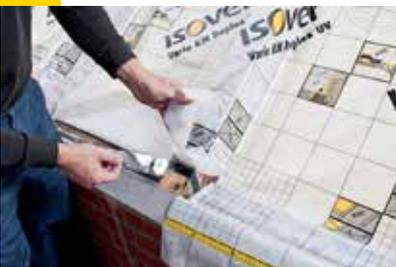
Den Liner des Dichtstoffes Vario® ProTape + Stück für Stück abziehen und die Folie faltenfrei ankleben. Zum optimalen Halt mit der Andruckrolle gut anrollen. Gleiches gilt für Folienanschluss an die Mauerwerkskronen im Giebelbereich. Alle Folienüberlappungen mit der Klebe-Dichtmasse Vario® DoubleFit + verkleben.
