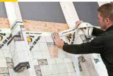
Wenn das Dach nicht bis in die Spitze gedämmt werden soll, sondern die oberste Geschossdecke (Kehlbalkenlage) den Abschluss der Dämmung bildet, wird eine geeignete OSB-Platte als sogenanntes Wechselbrett auf der Innenseite der Sparren oberhalb der einbindenden Decke angeschraubt. Ziel ist es, ein Medium zu schaffen, an das von beiden Seiten mit einer Folie und Klebebändern luftdicht angeschlossen werden kann.
