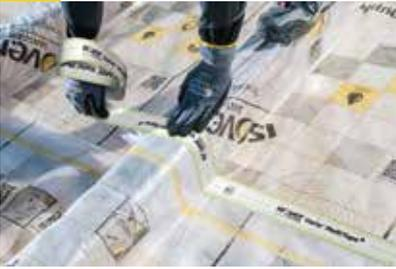
Den Überlappungsbereich der Bahnen mit ISOVER Vario® MultiTape + oder Vario® XtraTape mittig verkleben.
