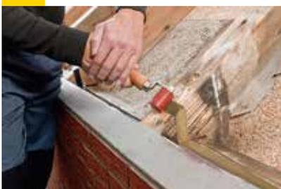
Spezialdichtstoff Vario® ProTape + im Traufbereich und an der Mauerkrone der Giebelwand auf die vorbehandelte Fläche abrollen und gut auf den Untergrund mit einer planen Gummiwalze faltenfrei andrücken. Den Liner erst kurz vor der Verklebung mit der Vario® KM Duplex UV entfernen. Dies schützt die Klebefläche vor Verschmutzung.
