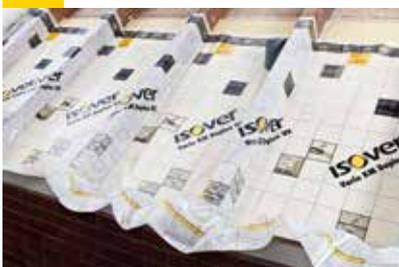
Vario® KM Duplex UV über die Sparren ausrollen, dabei waagrecht von der Traufe in Richtung First mit 10 cm Überlappung verlegen. Schrift lesbar zum Verarbeiter zeigend. Vorläufige Fixierung der Klimamembran im Gefach mit Handtacker. Bei der geraden Ausrichtung hilft das aufgedruckte Zuschnitttraster. Da die schlaufenförmig verlegte Folie im Traufbereich in Falten liegt, muss sie zur faltenfreien Verklebung eingeschnitten werden.
