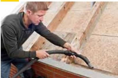
Bestehende Dacheindeckung abnehmen und alte Lattungen demonstrieren. Gefach leeren und säubern. Alte Dämmung fachgerecht entsorgen. Anschlussbereiche mit einer Drahtbürste von Staub, Schmutz und alten Dämmstoffresten säubern. Mit einem Staubsauger letzte Schmutzreste entfernen.
