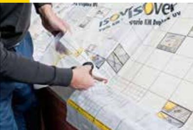
Um einen luftdichten Anschluss im Traufenbereich herzustellen sind 4 Schnitte erforderlich: 2 Schnitte bis zu den eingezeichneten Punkten links und rechts und 2 Schnitte in Verlängerung der Sparrenkanten. Die Klimamembran Vario® KM Duplex UV immer parallel zur Strichmarkierung einschneiden.
