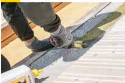
Bei einer gerade verlaufenden Mauerkrone kann die Klimamembran oben abgedichtet werden. Ist die Mauerkrone unregelmäßig oder abgestuft, muss die Folie an der Giebelwand angeschlossen werden. Die Anschlussbereiche müssen im Traufenbereich und an der Mauerkrone trocken, staub- und fettfrei sein. Zur optimalen Verklebung den Vario® MultiPrime mit einer Schaumwalze oder einem Pinsel auf den Untergrund auftragen und ablüften lassen.
