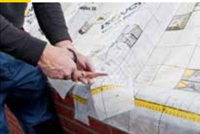
Die beiden äußeren Folienlappen auf eine Länge von rund 3cm einkürzen. Die Folie faltenfrei um die Sparrenflanken legen.
