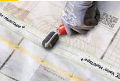
Abschließend alle Verklebungen mit einer planen Gummiwalze faltenfrei anrollen. Schaumstoffrollen bzw. gewölbte Rollen sind hierfür nicht geeignet.
