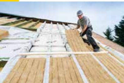
Isover Klemmfilz ins leere Gefach zwischen die Sparren klemmen. Dabei das Gefach vollständig bis Oberkante Sparren ausfüllen. Eindringen von Feuchte während des Bauablaufs bis zur endgültigen Dacheindeckung muss verhindert werden. Danach, je nach Konstruktion weitere Schichten wie z.B. Unterdeckbahn Isover ZUB oder Aufdachdämmung wie z.B. ISOVER Ultimate AP Platten verlegen und das Dach eindecken.
