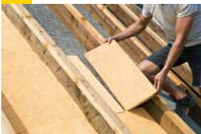
Integra UMP-032 Universal-Modernisierungsplatte als Nagelschutzplatte einlegen. Sie schützt die darüberliegende Dampfbremssfolie, wenn Nagelspitzen aus der Innenbekleidung herausstehen. Die Nagelschutzplatte wird auch bei offener Innenbekleidung (z.B. Nut- und Federbretter) benötigt. Gefachbreite ausmessen, Platten passend zuschneiden und ins Gefach dichtgestoßen einlegen. Reststücke im nächsten Gefach weiterverwenden.
