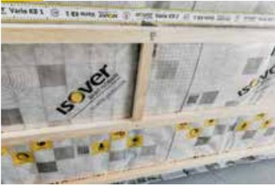
Gemäß ZVDH-Richtlinien müssen Wärmedämmungen so eingebaut werden, dass die Lagesicherheit und Funktion dauerhaft gewährleistet sind (z.B. mit Holzlatten 30 x 50 mm oder 60 x 60 mm). Der Abstand richtet sich nach der Art der Innenbekleidung. Ist keine Innenverkleidung geplant, sollte in der Dachschräge ein Achsabstand von 500 mm und an der Decke (waagrecht) von 400 mm nicht überschritten werden. Tipp! Bei der Montage der Querlattung ist eine Abstandshilfe hilfreich.
