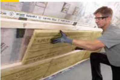
Der Untersparrenklemmfilz ULTIMATE UKF-034 twin wird bündig mit der Lattenunterkante endgültig in die richtige Position gebracht. Um Wärmebrücken zu verhindern und eine dauerhaft schadensfreie Konstruktion zu gewährleisten, den Untersparrenklemmfilz lückenlos und mit kompletter Dämmstoffdicke einbauen. Bei parallel, mit gleichem Abstand fixierter Traglattung und richtigem Zuschnitt kann bei der Einbringung des Dämmstoffes auf weitere Montagehilfen verzichtet werden. Das ist vor Ort zu prüfen.
