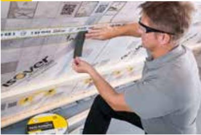
Sind die Sparren der Dachschräge nicht in einer Flucht, so kann die Traglattung z.B. über Stellschrauben ausgeglichen werden. Um zu verhindern, dass die Folie am Gewinde aufgerieben wird, sollte zuvor im Sparrenbereich auf die Dampfbremse das Nageldichtband Vario® AntiSpike aufgeklebt werden. Dies wird dann durch Antackern zusätzlich am Sparren fixiert. So ist die Durchdringung der Folie luftdicht. Alternativ zu den Stellschrauben eignen sich auch RIGIPS U-Direktabhänger 125.
