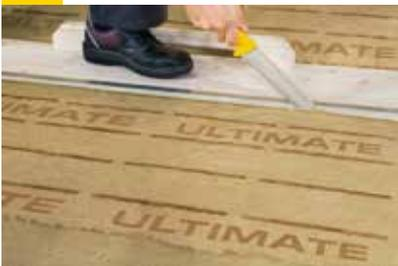
Der Untersparrenklemmfilz wird liegend an einer Führung (z.B. ein breites Brett mindestens 10 cm) entlang geschnitten. Schnittmaß (= Lichter Sparrenabstand + 0,5 cm). Mit dem Eigengewicht den Dämmstoff komprimieren und zuschneiden. Eine Schneidunterlage schützt empfindliche Untergründe und die Klinge des Dämmstoffmessers.
