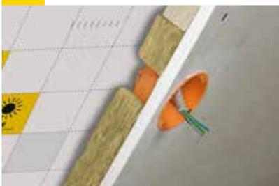
Sind Hohlwand Dosen in der Dachschräge geplant, sollte dies bei der Dimensionierung der Lattung berücksichtigt werden. In der so geschaffenen Installationsebene lassen sich Hohlwand Dosen und Kabel optimal integrieren. Hiermit wird die Anzahl der Durchdringungen durch die Klimamembran auf ein Minimum reduziert.
