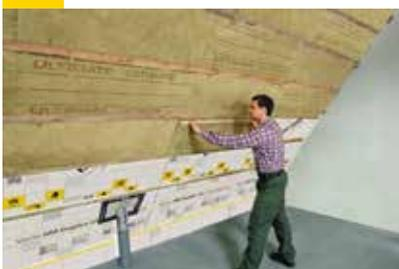
Liegt die Dampfbremse zwischen den Dämmschichten, dürfen pauschal nach ZVDH maximal 20% des gesamten Wärmedurchlasswiderstandes unter der Dampfbremse liegen. Dieser Anteil kann mit dem Einsatz der ISOVER Vario® Klimamembran durch ihr Rücktrocknungsvermögen auf etwa ein Drittel ohne rechnerischen Nachweis ausgeweitet werden. Ausführungsvarianten finden Sie in der Broschüre «ProfiWissen Dach» unter Kapitel «ergänzende Untersparrendämmung».
