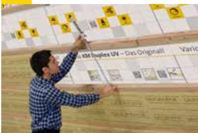
Bei der anschließenden Montage der Innenbekleidung, z.B. Rigips Bauplatten mit einer Länge von 2000 mm oder 2500 mm, sollten Achsabstände von 500 mm für die Holzunterkonstruktion eingehalten werden. Die GK-Platten werden dann hochkant an die Holz-Unterkonstruktion, gemäß den Herstellerangaben angeschraubt. Die Holzlatten sollten der Sortierklasse S 10 nach DIN 4074 Teil 1 mit einer Restfeuchte unter 20 % entsprechen.
