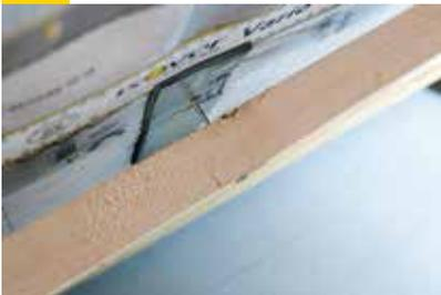
Wird der Abstand der Latte zum Sparren zu groß, und die Zwischensparrendämmung drückt auf die Dampfbremse, muss eine weitere Anpresslatte (z.B. 24 / 48 mm) zu Lagesicherung quer zu den Sparren verschraubt werden. Dies verhindert Spannungen an den Tackerstellen und den Klebeverbindungen.
