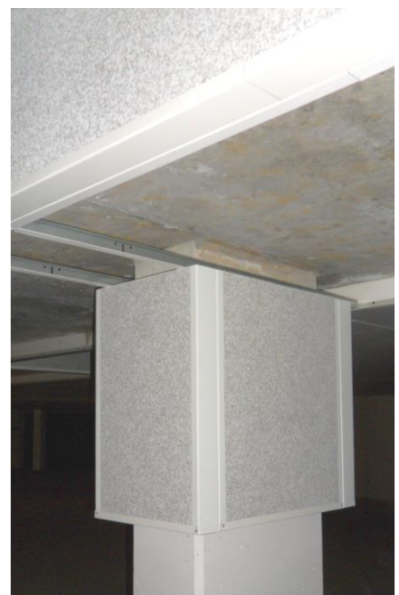
Stütze: Topdec DP 1 Schienenm.
