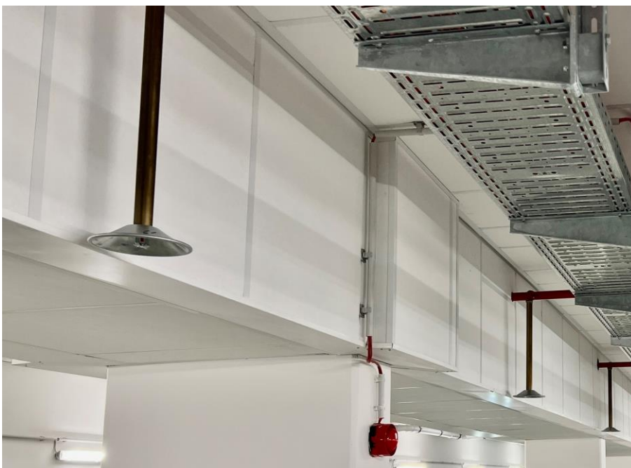
Unterzug: Topdec DP 1 Schienenmontage
