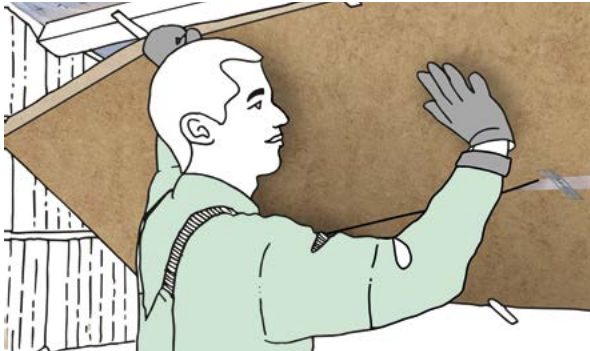
Eine lückenlose Untersparrendämmung aus Mineralwolle minimiert Wärmebrücken im Bereich der Dachsparren.
