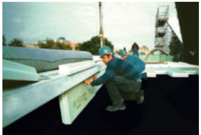
Abb. 14: Attika-Dämmung mit Styrodur®.
