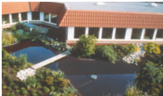
Abb. 23: Begrünte und begehbare Dachterrasse mit Anstau-bewässerung in Folienteichen über einer Umkehrdachkonstruktion mit ganzflächiger Kiesdränschicht.
