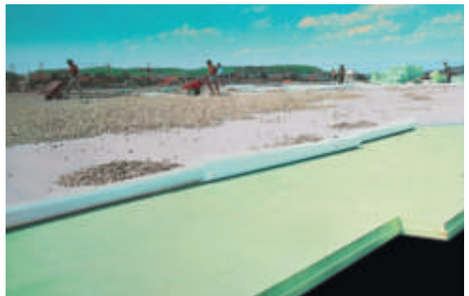
Abb. 9: UK-Dach mit Trennlage und Kiesschüttung.
