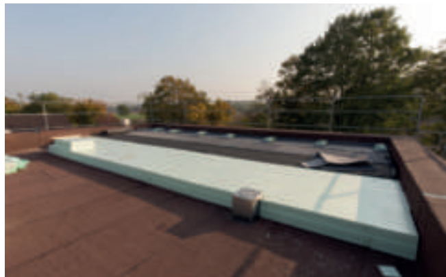
Abb. 1: Styrodur® ist aufgrund seiner Druckfestigkeit, geringen Wasseraufnahme und geringen Wärmeleitfähigkeit für UK-Dachkonstruktionen hervorragend geeignet, z. B. bei Flachdachsanierungen als Plus-Dach.
