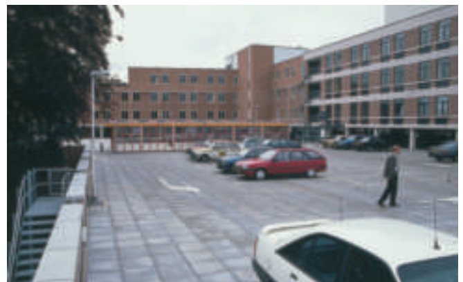
Abb. 43: Parkdach mit Betonplatten auf UK-Dach mit Styrodur®.
