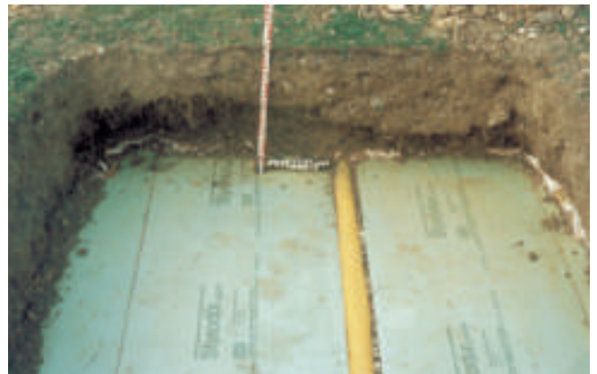
Abb. 6: Bild zeigt ein über 30 Jahre altes, begrüntes Umkehrdach
