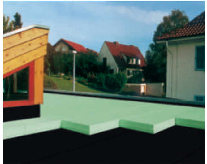
Abb. 25: Verlegung von Styrodur®-Platten unter extensiver Dachbegrünung.
