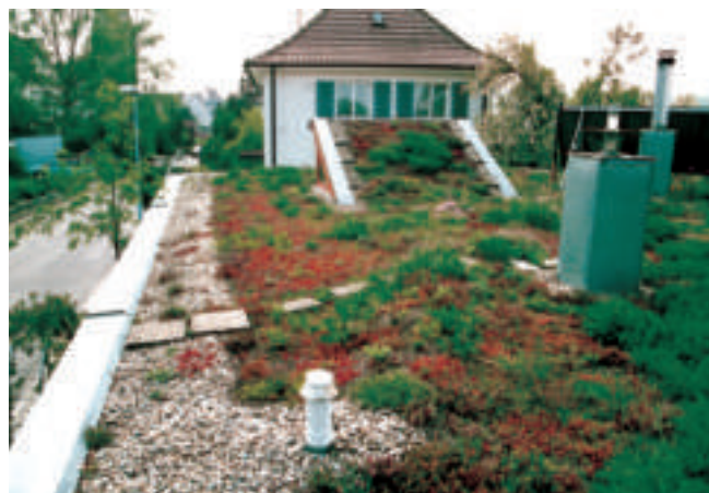
Abb. 35: Kiesstreifen am Dachrand und an Dachdurchdringungen.
