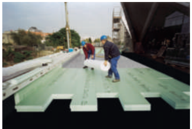
Abb. 15: Verlegung von Styrodur® oberhalb der Dachabdichtung.
