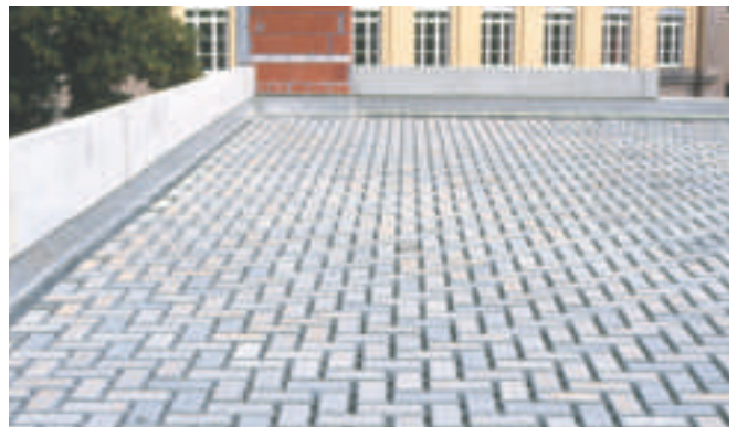
Abb. 47: Verlegtes Betonpflaster auf Styrodur®.
