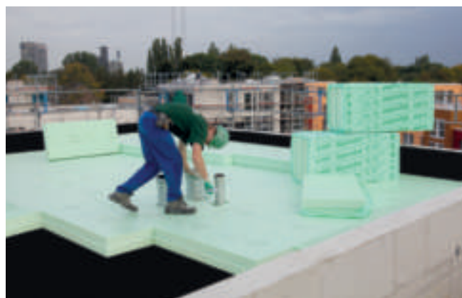
Abb. 3: UK-Dach-Dämmung mit Styrodur® von 250 Wohneinheiten in Hamburg.
