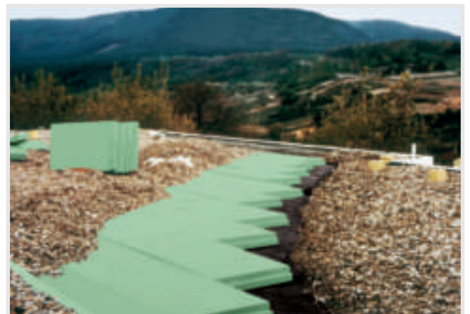
Abb. 18: Saniertes UK-Dach als Plusdachkonstruktion.
