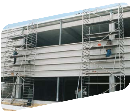
Leere Stahlkassetten vor der Dämmstoffverlegung
