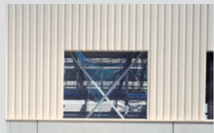
Fertig montierte Außenschale
