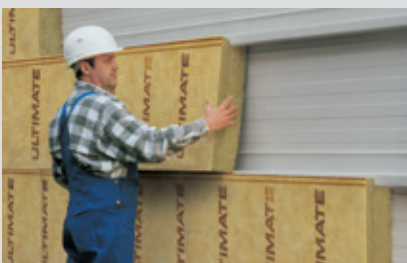
Verlegung von ULTIMATE Metac WS-PLUS-032-RLR
