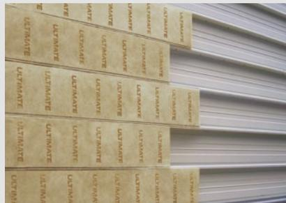
Mineralwolle-Filze überdecken die Stege und reduzieren Schallbrücken
