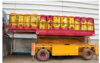
Logistikvorteile auf der Baustelle – so passt nahezu doppelt so viel Rollenware auf die Hubbühne und bei Arbeiten mit einem Gerüst passen die Rollen sogar durch die Durchstiegsöffnung.
