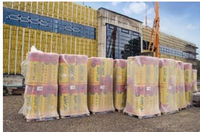
Ein klarer Vorteil für Lagerung und Logistik. Die Rollenware nimmt im Vergleich zu Plattenware nur rund die Hälfte an Platz ein. Damit passt die doppelte Dämmmenge auf eine Palette.
