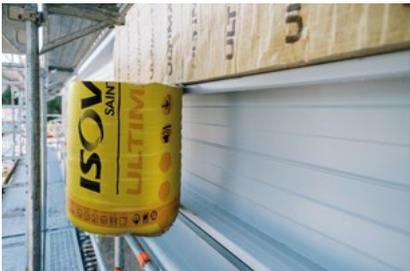
Der Einbau ist schnell und einfach. In einem Arbeitsschritt werden je nach Dämmdicke bis zu 5 m Filz am Stück in die Kassette eingebracht.
