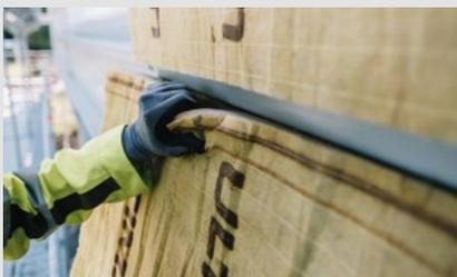
Dämmplatte oder Filz in die Wandkassette einsetzen. Die **Markierung** zeigt die Seite mit dem Einschnitt, der den Kassettensteg aufnimmt.
