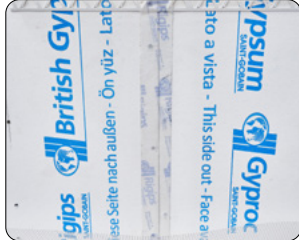
Rigips Glasroc X Gipsplatten, Stoß mit Fugenband abgeklebt
