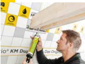
Die Holzbalken im Altbau an der Klebestelle mit der Stahlbürste zuerst gründlich von Staub und Schmutz reinigen. Bei Bedarf Untergrund mit Primer vorbehandeln und ablüften lassen. Die Balkenrisse reichlich mit KlebeDichtmasse Vario® DoubleFit + ausspritzen. Dabei die Dichtraupe zur optimalen Abdichtung einige Zentimeter vor der Klebestelle hinaus verlängern. Einzelheiten siehe Verarbeitungsrichtlinie Balken- bzw. Zangenanschluss mit Manschette oder Klebeband.
