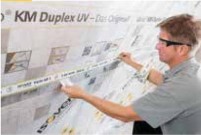
Nachdem die Klimamembran angebracht wurde, muss zeitnah die Stoßverklebung erfolgen. Andernfalls besteht das Risiko, dass Staub oder Baustellenschmutz eine wirkungsvolle Verklebung beeinträchtigen. Folienstoß mittig 3 cm überlappend, luftdicht auf der glatten Seite mit dem Klebeband Vario® KB 1 oder Vario® MultiTape verkleben. Die Strichmarkierung auf der Folie dient hier als Orientierung.
