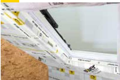
Achtung! Sämtliche Anschlüsse an angrenzende Bauteile (wie z.B. Dachflächenfenster, Dachgauben, Schornstein) und Durchdringungen der Klimamembran (wie z.B. Entlüftungsröhre, Haustechnik Leitungen) müssen mit ISOVER Vario® Systemkomponenten luftdicht ausgeführt werden. Um Feuchteschäden zu vermeiden sind alle Bauteilanschlüsse und Durchdringungen der Klimamembran zeitnah nach der Montage der Folie luftdicht auszuführen.
