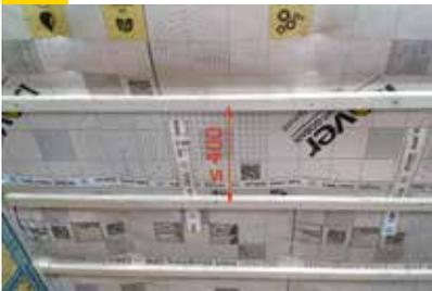
Sollte die Wärmedämmung mit Einblaswolle durchgeführt werden, kann die Vario® KM Duplex UV unter bestimmten Voraussetzungen eingesetzt werden. In diesem Fall beträgt der Maximalabstand der Querlatten 400 mm. Im Bereich der Stoßverklebung ist einmal mittig im Sparrengefach ca. 30 cm Vario® KB 1 oder Vario® MultiTape + senkrecht über die Stoßverklebung zu setzen.
