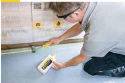
An den Anschlussbauteilen wie z.B. Bodenanschluss die Klimamembran hochschlagen und mit Kreppband fixieren. Vario® MultiPrime mit einer Schaumwalze oder einem Pinsel auf den Untergrund auftragen und ablüften lassen. Die provisorisch fixierte Klimamembran lösen und Entlastungsschlaufe mit ca. 3 cm Materialzugabe als Bewegungsfuge legen. Verklebung mit Klebe-Dichtmasse Vario® DoubleFit + oder Vario® ProTape + wie oben beschrieben durchführen.
