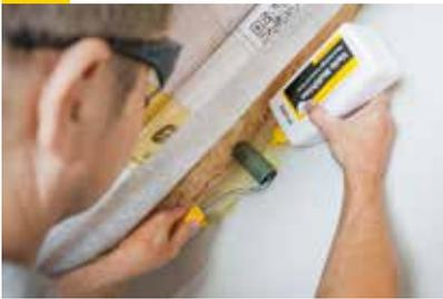
Vor dem Anschließen der Klimamembran an die Wand muss diese begutachtet werden: Bei stark bröselndem, offenporigem oder unebenem Wandmaterial muss der Untergrund durch Glattstrich optimiert werden. Dies gilt auch für unverputzte Wandflächen. Der Primer Vario® MultiPrime schafft zusätzlichen Haftverbund. Nach Auftragen den Haftvermittler kurz Ablüften lassen bis die Oberfläche nicht mehr nass ist.
