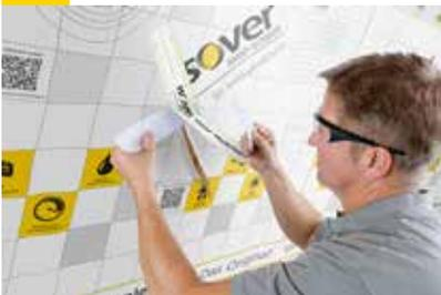
Ausgerissene Tackerlöcher oder Beschädigungen der Klimamembran mit dem Klebeband Vario® KB 1 oder Vario® MultiTape verschließen. Tackerklammern müssen bei festem Sitz nach der DIN 4108-7 nicht überklebt werden.
