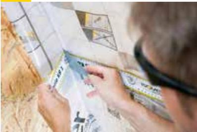
Um eine effektive Eckverklebung zu erreichen, das Klebeband mit einem Spachtel oder einer Rakel sorgfältig in die Ecken drücken. Zur sicheren Verarbeitung immer nur so viel Liner des Klebebands abziehen, wie gerade benötigt wird.
