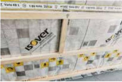
Gemäß ZVDH-Richtlinien müssen Wärmedämmung und Luftdichtebene so eingebaut werden, dass die Lagesicherheit und Funktion dauerhaft gewährleistet sind (z.B. mit Holzlatten oder Metallprofilen). Der Abstand richtet sich nach der Art der Innenbekleidung. Ist keine Innenverkleidung geplant, sollte in der Dachschräge ein Abstand von 500 mm und an der Decke (waagrecht) von 400 mm nicht überschritten werden.
