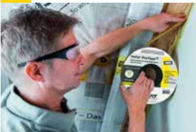
Das Dichtband Vario® ProTape + an der Giebelwand mit geringem Abstand zur Dachschräge anbringen. Die Klebeflügel mit zwei Fingern an beiden Seiten des Schaumkernes andrücken. Die provisorisch fixierte Klimamembran lösen und Entlastungsschlaufe mit ca. 3 cm Materialzugabe als Bewegungsfuge legen. Dann erst Liner lösen und die Folie V-förmig am Dichtband andrücken. Das Anrollen der Verklebungen mit einer planen Gummiwalze erhöht die Klebekraft deutlich.
