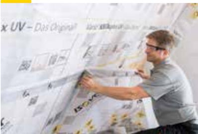
Vario® KM Duplex UV wird mit glatter, bedruckter Seite zum Verarbeiter hin eingebaut. Die Klimamembran bahnenweise, von oben beginnend mit 10 cm Überlappung am Sparren gerade und spannungsfrei antackern. Der Abstand der Tackerstellen sollte 20 cm nicht überschreiten. Schlagtacker sind für diese Anwendung nicht geeignet.
