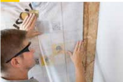
Für den Anschluss der Vario® KM Duplex UV an die Giebelwand ist für die Bildung einer Entlastungsschleife ein Materialüberschuss von mindestens 10 cm erforderlich. Die Klimamembran zurückschlagen und mit Kreppband provisorisch fixieren. Dazu keine Vario Klebebänder benutzen, da diese eine sehr starke Klebekraft haben und sich nicht mehr lösen lassen.
