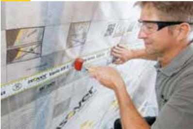
Abschließend alle Verklebungen mit einer planen Gummiwalze faltenfrei anrollen. Schaumstoffrollen bzw. gewölbte Rollen sind hierfür nicht geeignet. Alternativ eignet sich auch eine Kunststoff-Rakel mit abgerundeten Ecken.
