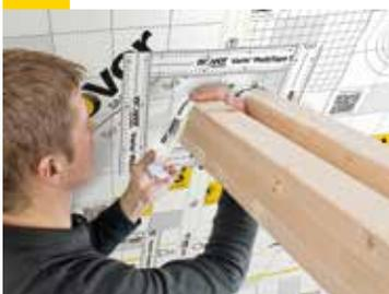
Um einen zuverlässig luftdichten Anschluss der Vario® KM Duplex UV an einen Balken sicherzustellen, muss die Klimamembran passgenau zugeschnitten werden und bündig mit dem Balken abschließen. Das ist aber nicht in allen baulichen Situationen realisierbar. In solchen Fällen empfiehlt sich das Abdichten mittels einer Manschette. Einzelheiten siehe Verarbeitungsrichtlinie Balken- bzw. Zangenanschluss mit Manschette oder Klebeband.
