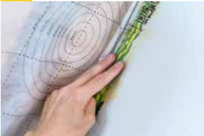
Die Klebe-Dichtmasse Vario® DoubleFit + mit geringem Abstand zur Dachschräge mit Raupendurchmesser von 6-8 mm mit guter Haftung zum Untergrund auftragen. Die provisorisch fixierte Klimamembran lösen und Entlastungsschlaufe mit ca. 3 cm Materialzugabe als Bewegungsfuge legen. Die Dampfbremsfolie zwischen zwei Fingern an die Raupe drücken, so dass die Dicke der Klebe-Dichtmasse in der Mitte der Raupe nach dem Andrücken noch > 4 mm und an den Rändern 1-2 mm beträgt.
