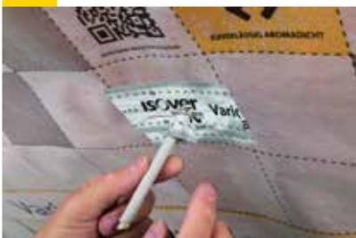
Bei Kabeldurchdringungen die Kabelzwischenräume zur Abdichtung mit der Klebe-Dichtmasse Vario® DoubleFit + reichlich ausspritzen. Alle Kabel zusammenfassen und mit Klebeband bündeln. Rings um das Kabelbündel Vario® DoubleFit + zur Abdichtung auftragen. Anschließend Vario® MultiTape SL + von unten und oben spannungslos ankleben.
