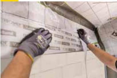
Das Einputzband Vario® Bond ist für die Montage der Klimamembran an unverputztem Mauerwerk geeignet. Bei sandigen oder saugenden Untergründen mit Vario® MultiPrime den Klebebereich vorbehandeln. Vario® Bond mind. 3 cm auf Damfbremse, restliche 12 cm vollflächig auf angrenzenden Untergrund verkleben. Entlastungsschlaufe im Randbereich legen. Der Putz in einem Streifen von mind. 3 cm über das Einputzband, direkt im Anschluss führen damit ein luftdichter Übergang entsteht.
