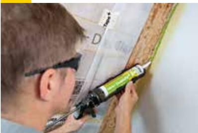
Unabhängig von der Ausführungsvariante der Verklebung an die Giebelwand, die Folienbahnen im Überlappungsbereich (10 cm) und in den Ecken stets mit Dichtstoff Vario® DoubleFit + abdichten.
