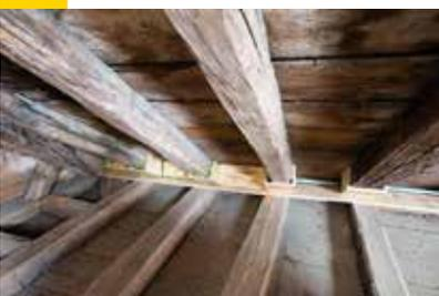
Alle Fugen zwischen OSB-U-Profil und Sparren mit pastöser 2-Komponenten- Dichtmasse Vario® DoubleFit + ausspritzen.
