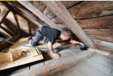
OSB-Streifen entsprechend ausklinken und waagrecht an die Holzbalken oder an die Holzschalung der Decke anschrauben oder annageln. Die OSB Streifen sollten nach der Montage von der Dachraumseite vor den Sparren ca. 10 cm. in den Raum auskragen.
