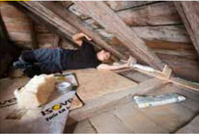
Ist der Spalt zwischen hinterer Kante des OSB Streifens der Pos. 3 und der Dachschalung zu groß, um ihn mit pastöser Dichtmasse zu füllen, werden aus flexiblem Glaswolle-Dämmstoff, Folie und Klebeband „Kissen“ in Länge des Sparrenabstandes vorbereitet. Die Kissen werden passgenau im Gefach in den Spalt gedrückt.
