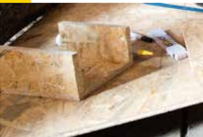
Bei Sanierungsobjekten mit abgerundeten oder verdrehten Sparren im Bestand, ist eine Vorbereitung von U-Profilen hilfreich. Dafür Sparrenbreite und -tiefe ausmessen und passende U-Profile aus OSB zusammenbauen. Die innere Ecken des U-Profils mit Vario® DoubleFit + abdichten.
