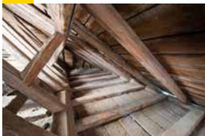
Um die alte Traufpfette gibt es zahlreiche Bereiche mit undichten Stellen. Um nachhaltig die Durchströmung der Decke durch Leckagen zu verhindern, sind diese abzudichten. Als Vorbereitung, sind alle Flächen im Traufbereich zuerst von groben Schmutz zu befreien und bei Bedarf mit einer Drahtbürste zu reinigen. Abschließend werden die Flächen mit Industriestaubsauger abgestaubt und bei Bedarf mit Vario® MultiPrime grundiert.
