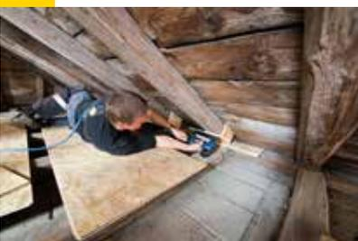
U-Profile an die Sparren anschrauben. Ziel ist es, die Schnittstelle zwischen Bodenfläche und Dachschräge aus Holz luftdicht herzustellen, als saubere Basis für die folgenden Anschlüsse mit Folien, Klebebändern und Dichtstoff. So wird mit dem OSB-U-Profil aus einem abgerundeten Sparren ein Rechteckquerschnitt, an den ordentlich angeschlossen werden kann.
