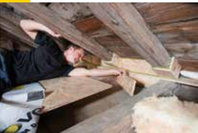
Bei Bedarf, kann ein weiteres Stellbrett den unteren Raum zwischen den Deckenbalken verschließen. Nach der Montage, müssen auch hier alle Ecken mit der Dichtmasse abgedichtet werden. Damit enden die Vorbereitungsmaßnahmen an der Traufe und die Auslegung der Klimamembran kann beginnen.
