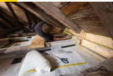
Je nach Sanierungsfall, an der Traufe die Folienpassstücke für den Randanschluss anzeichnen und zuschneiden. Die Passstücke mit Vario® DoubleFit + Dichtmasse oder Vario® MultiTape + an die OSB Platte ankleben.
