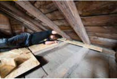
Die Hilfsmaßnahmen für die Vorbereitung einer geeigneten Fläche für spätere Verklebungen werden durch entsprechende Passtücke aus OSB Platte gefertigt. Um später eine dauerhafte Verklebungen zu gewährleisten sollte die Oberfläche der OSB Platte leicht angeschliffen und abgestaubt werden. Als erstes die OSB-Streifen auf die Deckenbalken legen und die Sparrenbreite anzeichnen.
