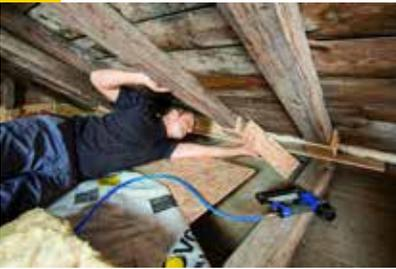
Das lichte Abstandsmaß zwischen den OSB-U-Profilen bildet die Länge der Stellbretter, die ebenfalls aus OSB-Platten vorzubereiten sind. Die Breite der Stellbretter ergibt sich aus der lotrechten Höhe der U-Profile. Mit dem Nagler oder Akkuschauber werden die Stellbretter bündig zwischen den U-Profilen befestigt.
