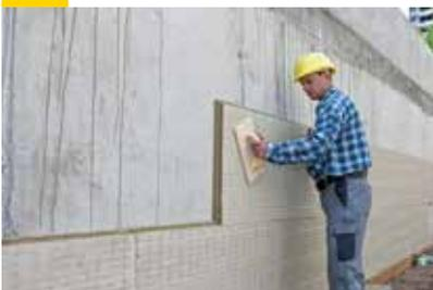
Die Akustic HWP1 Platten werden dicht gestoßen mit vollflächig aufgetragenem Baukleber an der zunächst betonierten Wandschale fixiert. Der Untergrund muss ausreichend eben sein. Wenn im Einzelfall Schwierigkeiten bei der Beurteilung der Eignung von Untergründen auftreten, sind Zusatzmaßnahmen zu treffen und entsprechende Vorbehandlung der Untergründe festzulegen. (Z. B. notwendige Begrädigung oder Grundierung nach Rücksprache mit der Herstellerfirma des Klebemörtels)
