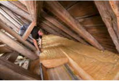
An allen aufgehenden Bauteilen sind die Filze so anzuschneiden, dass keine Hohlräume verbleiben. Bei Durchdringungen die Dämmschicht sorgfältig schließen.
