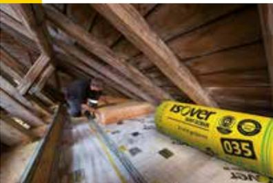
Filz mit den Ausklinkungen bis ans Stellbrett an der Traufe schieben. Bei Bedarf Lücken mit loser Wolle stopfen.
