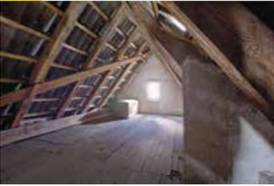
Holzbalkendecken: Die Klimamembran kann eben, von oben auf der Holzbalkendecke verlegt werden, wenn die Bestandsdecke a) nicht gedämmt ist oder b) die bereits verbaute Dämmschicht nicht mehr als ca. 30% der Gesamtdämmwirkung abdeckt. Bei einer Bestandsdecke mit 80 mm Mineralwolle in WLG 040 oder 140 mm Strohlehm-Gemisch muss, zur Vermeidung von Tauwasserausfall, der Topdec DF 1-035 RENO in der Stärke von mindestens 140 mm verlegt werden.
