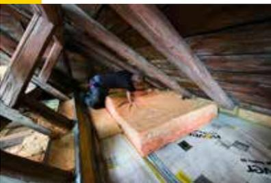
Zuerst den Filz vor die Traufkonstruktion schieben und die Ausschnitte für die Sparren mit dem Messer markieren. Dann jeden Sparren ausklinken. Um den Glaswolle-Deckenfilz zu schneiden empfehlen wir das ISOVER Dämmstoff-Messer mit glatter Klinge.
