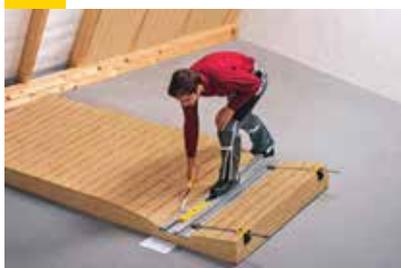
Betondecken: Rissfreie Betondecken im Bestand kommen aufgrund ihres hohen Diffusionswiderstands ohne dampfbremsende Schicht aus. Bei Neubauten ist auf die Restfeuchte der Betondecke zu achten! Gegebenenfalls ist eine Feuchtigkeitssperre aufzubringen.
