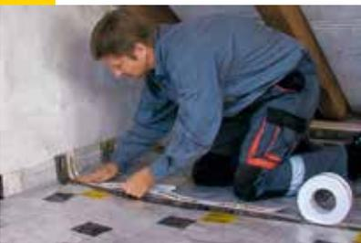
Die Folie bahnenweise verlegen und die Überlappung der Folienstöße mit Vario® KB 1, Vario® MultiTape oder Vario® XtraTape verkleben. Gute Orientierung bietet der Aufdruck am Folienrand.
