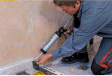
Zusätzliches Abdichten der Bahnenüberlappungen an den Wandanschlüssen mit dem Dichtstoff Vario® DoubleFit oder Vario XtraFit.
