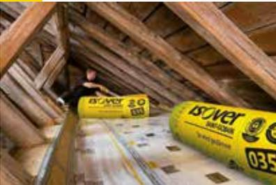
Sobald die Abdichtungsarbeiten fertiggestellt sind, folgt die Dämmung mit Topdec DF 1-035 RENO. Der Dämmstoff wird einfach auf der Bodenfläche ausgerollt. Er ist auch für die Verlegung auf unebenen Untergründen optimal geeignet. Der Zuschnitt erfolgt einfach mit Dämmstoffmesser und Schneidbrett. Praxistipp: Eine Schneidunterlage schützt die Dampfbremssfolie vor Beschädigung.
