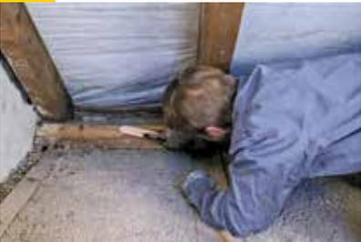
Vorbereitung: Reinigen der Anschlussbereiche an Wand und Holzbalken mit Drahtbürste und Staubsauger zum klebesicheren Anbringen von Vario® DoubleFit, Vario® XtraFit oder Vario® ProTape Plus. Ggf. den Untergrund mit Haftvermittler Vario® MultiPrime vorbehandeln.
