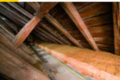
Nach den anfänglich aufwendigeren Anpassarbeiten der ersten Dämmstoffbahn, werden alle weiteren Dämmstoffbahnen nur noch ausgerollt, zusammengeschoben und lückenlos verlegt.
