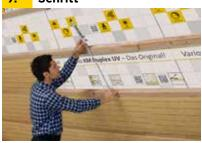
Bei der anschließenenden Montage der Innenbekleidung, z.B. Rigips Bauplatten mit einer Länge von 2000 mm oder 2500 mm, sollten Achsabstände von 500 mm für die Holzunterkonstruktion eingehalten werden. Die Platten werden dann hochkant an die Holz-Unterkonstruktion verschraubt. Die Holzlatten sollten der Sortierklasse S 10 nach DIN 4074 Teil 1 mit einer Restfeuchte unter 20 % entsprechen.
