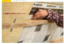
Der Integra UMB Untersparren-Montagebügel wird hinter die Latte eingeschoben. Die beiden Flügel fixieren den Untersparren-Klemmfilz bis die Innenbekleidung montiert wird.
