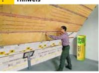
Liegt die Dampfbremse zwischen den Dämmschichten, dürfen pauschal nach ZVDH maximal 20% des Wärmedurchlasswiderstandes unter der Dampfbremse liegen. Dieser Anteil kann mit dem Einsatz der ISOVER Vario® Klimamembran durch ihr Rücktrocknungsvermögen auf etwa ein Drittel ohne rechnerischen Nachweis ausgeweitet werden. Ausführungsvarianten finden Sie in der Broschüre «ProfiWissen Dach» unter Kapitel Ergänzende Untersparrendämmung.
