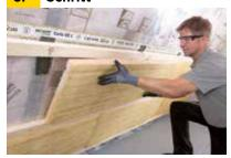
Der Untersparren-Klemmfilz Integra UKF-032 / 035 kann jetzt bündig mit der Lattenunterkante endgültig in die richtige Position gebracht werden. Um Wärmebrücken zu verhindern und eine dauerhaft schadensfreie Konstruktion zu gewährleisten, sollte der Untersparrenklemmfilz lückenlos und mit kompletter Damstoffdicke eingebaut werden.
