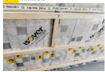
Gemäß ZVDH-Richtlinien müssen Wärmedämmungen so eingebaut werden, dass die Lagesicherheit und Funktion dauerhaft gewährleistet sind (z.B. mit Holzlatten 30 x 50 mm, 40 x 60 mm oder 60 x 60 mm). Der Abstand richtet sich nach der Art der Innenbekleidung. In der Dachschräge darf ein Abstand von 500 mm und an der Decke (waagerecht) von 400 mm nicht überschritten werden. Tipp! Bei der Montage der Querlattung ist eine Abstandshilfe hilfreich.
