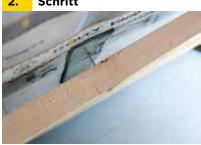
Wird der Abstand der Latte zum Sparren zu groß, und die Zwischensparrendämmung drückt auf die Dampfbremse, muss eine weitere Latte in passender Abmessung zur Lagesicherung direkt auf den Sparren verlegt werden. Dies verhindert Spannungen an den Tackerstellen und den Klebeverbindungen.
