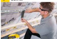
Sind die Sparren der Dachschräge nicht in einer Flucht, so kann die Traglattung z.B. über Stellschrauben ausgeglichen werden. Um zu verhindern, dass die Folie am Gewinde aufgerieben wird, sollte zuvor im Sparrenbereich auf die Dampfbremse das Nageldichtband Vario® AntiSpike aufgeklebt werden. Dies kann dann durch Antackern zusätzlich am Sparren fixiert werden. So ist die Durchdringung der Folie luftdicht. Alternativ zu den Stellschrauben eignen sich auch RIGIPS U-Direktabhänger 125.
