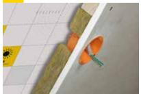
Sind Hohlwanddosen in der Dachschräge geplant, sollte dies bei der Dimensionierung der Lattung berücksichtigt werden. In der so geschaffenen Instalationsebene lassen sich Hohlwanddosen und Kabel optimal integrieren. Hiermit wird die Anzahl der Durchdringungen durch die Klimamembran auf ein Minimum reduziert.
