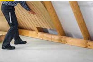
Den schräg angeschnittenen Klemmfilz im Gefach lückenlos bis zur Fußpfette bzw. Decke nach unten einschieben.
