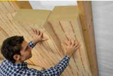
Die Reststücke einer Rolle lassen sich im nächsten Gefach kombiniert verwenden. So entsteht nahezu kein Abfall. Es ist darauf zu achten, dass der Spalt zwischen Giebelwand und den letzten Sparren mit Mineralwolle vollständig ausgefüllt wird.
