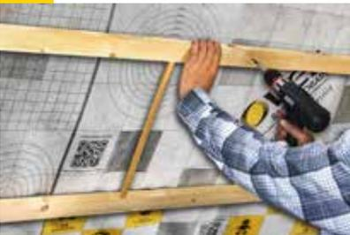
Die Klemmwirkung von Klemmfilzen ist nur eine temporäre Einbauhilfe (bis zum Aufbringen einer Lattung oder Innenbekleidung) und keine dauerhafte Lagesicherung. Daher ist in jedem Fall, auch wenn keine Innenbekleidung angebracht oder die Decke abgehängt wird, die Dämmstoff- & Luftdichtebene durch Metallprofile oder eine Holzlattung mechanisch zu sichern. Einzelheiten siehe Verarbeitungsrichtlinien: Einbau der Vario Klimamembranen und Einbau der Untersparrendämmung.
