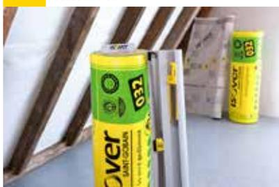
Für die Zwischensparren-Dämmung von innen werden folgende Werkzeuge benötigt: Zollstock, Dämmstoffmesser und Integra Fast-Cut mit Schneideunterlage. Alternativ kann auch ein Brett als Schneidehilfe verwendet werden.
