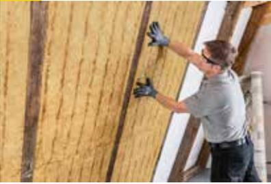
Der Klemmfilz kann jetzt bündig mit der Sparrenunterkante endgültig in die richtige Position gebracht werden. Um Wärmebrücken zu verhindern und eine dauerhaft schadensfreie Konstruktion zu gewährleisten, sollte der Klemmfilz lückenlos und mit kompletter Dämmstoffdicke eingebaut werden.
