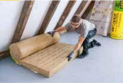
Dämmstoffrolle gegen eine Wand ausrollen. Das ist platzsparender und wirbelt weniger Baustellenschmutz auf.
