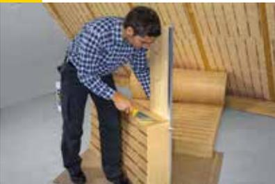
Dämmstoff an der Traufpfette, Mittelpfette oder Firstpfette schräg anschneiden, um Hohlräume und Wärmebrücken zu vermeiden. Neigungswinkel der Sparren mit einer Schmiege abnehmen und auf den Klemmfilz übertragen. Zum anschneiden der Schräge den Klemmfilz hochkant aufstellen und entlang einer stabilen Kante zuschneiden.
