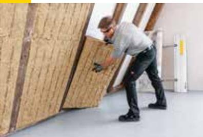
Den Zuschnitt Integra ZKF 1-032/035 bündig an den Sparren anlegen und die gegenüberliegende Seite in das Gefach schieben.
