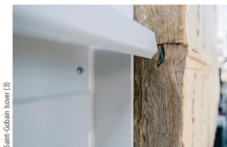
Bei Wandkassetten-Dämmsystemen mit sogenannter Stegüberdeckung kann man den Zwischenraum zwischen der inneren und äußeren Schale dämmen und gleichzeitig die Kassettenstege mit 40 oder 80 mm Mineralwolle überdecken.
