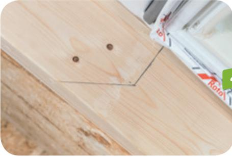
4 Die Kontur des Dämmstoffkeils ist nun definiert.
