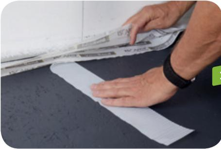
Zum Bodenanschluss mit Vario® Bond an das Mauerwerk auf porösen Untergründen oder auf OSB mit Vario® MultiPrime vorbehandeln (s. Seite 53 Bild 1).
