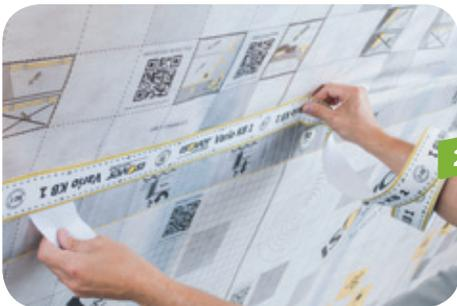
Die Folienbahnen werden dazu mit Klebeband Vario® KB 1 oder Vario® MultiTapet+ 3 cm überlappend verklebt. Die Strichmarkierung auf der Folie dient hier als Orientierung.
