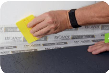
Danach Vario® Bond am Mauerwerk und am Boden vollflächig mit Rakel oder Anpressrolle andrücken.
