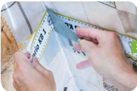
Um eine effektive Eckverklebung zu erreichen, das Klebeband mit einem Spachtel oder Rakel sorgfältig in die Ecken drücken. Zur sicheren Verarbeitung immer nur so viel Liner des Klebebands abziehen, wie gerade benötigt wird.
