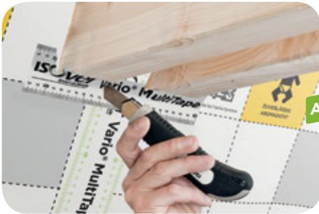
Die zweite Liner-Spur des Klebebands lösen und am Balken festkleben. An den Balkenkanten das Klebeband gemäß der Abbildung mit einem Cutter einschneiden und festkleben.
