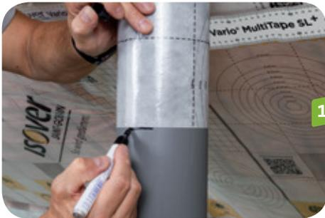
**13** Wird die luftdichte Ebene an HT-, bzw. KG-Rohren angedichtet, muss die Klebestelle aufgeraut werden. Dazu die Unterkante des zweiten Foliensstücks vor dem Verkleben am Rohr anzeichnen.
