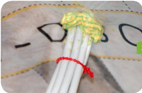
Alle Kabel zusammenfassen und mit einem Klebeband oder einem Kabelbinder bündeln.
