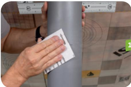
**14** Die angezeichnete Klebestelle mit Verdünnung reinigen und Oberfläche mit Schleifpapier oder mittels Cutter aufrauen. So ist sie für eine optimale Klebeverbindung zwischen Klebeband und Rohr vorbereitet.
