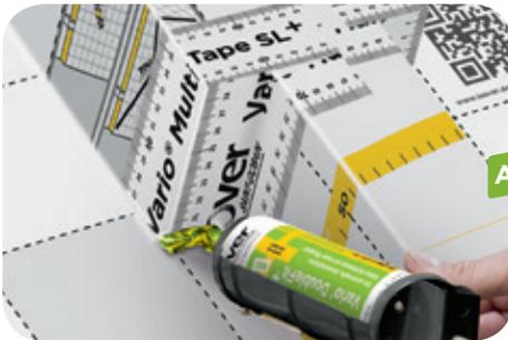
Mit allen offenen Kanten wie in A5 beschrieben verfahren. Anschließend zur Abdichtung die Klebe-Dichtmasse Vario® DoubleFit+ an alle Eckpunkte spritzen.
