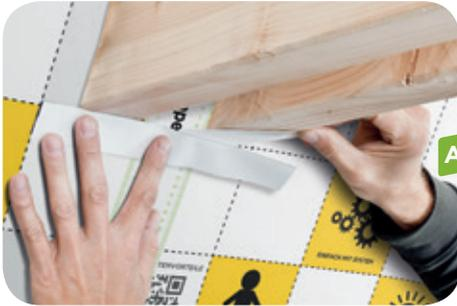
Das Klebeband Vario® MultiTape SL+ zuerst an den kurzen Seiten mit dichtem Anschluss an den Balken auf die Folie kleben. Nur eine Liner-Spur abziehen.
