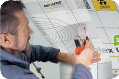
Das an den Fensterseiten fehlende Folienmaterial anfügen. Dazu zwei Streifen mit Überlänge zuschneiden und z. B. mittels Drucktacker befestigen. Es empfiehlt sich den zu verklebenden Folienstoß am Sparren (falls vorhanden) zu positionieren. Bei der Stoßverklebung ist hier ein besserer Anpressdruck vorhanden.
