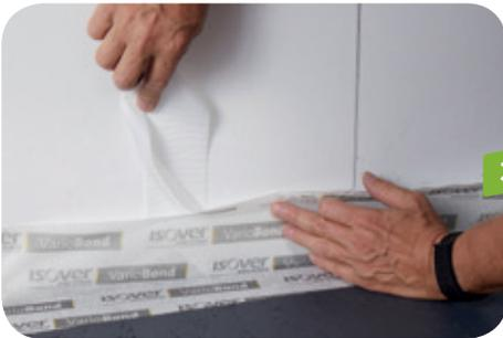
Dann die Verklebung an das Mauerwerk durchführen, in dem das schmalere Abdeckband abgezogen wird. Bei Vario® Bond 150 muss zunächst das mittlere Band zur Verklebung abgezogen werden und danach das äußere.
