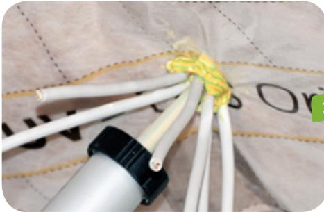
Bei Durchdringungen von Mehrfachkabeln zunächst die Zwischenräume der Kabel mit der Klebe-Dichtmasse Vario® DoubleFit + ausspritzen.
