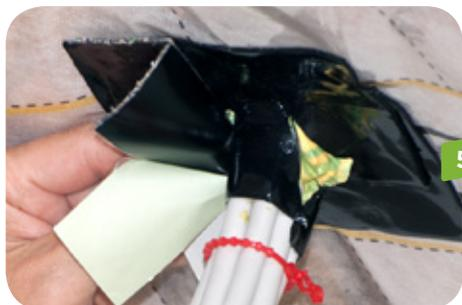
Die drei verbliebenen Seiten des Kabelbündels wie oben beschrieben mit je einem Streifen Vario® Stretch luftdicht abdichten.
