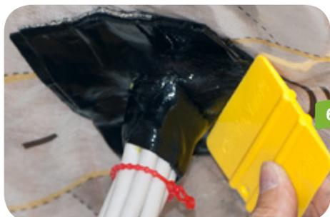
Abschließend Vario® Stretch ohne Beschädigung fest bis in die Ecken drücken, z.B. mit Hilfe eines Rakels.
