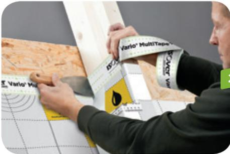
Das Wechselbrett von außen an die Klimamembran anschließen. Beim Verkleben mit Vario® MultiTape+ das Klebeband mit einem Spachtel gut in die Kanten drücken. Zum optimalen Halt das Klebeband mit einer Anpressrolle / Rakel anrollen. Gegebenenfalls die Ecken mit Vario® DoubleFit+ ausspritzen.
