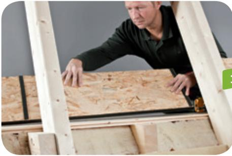
Brettstöße von innen mit Vario® MultiTape+ verkleben. Bei unebener Auflage des Wechselbrettes am Sparren mit Dichtband Vario® AntiSpike Bereiche bekleben. Dann das Wechselbrett von innen (Spitzboden) an die Balken schrauben.
