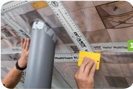
**12** Drücken Sie die Verklebung mit Rakel oder Handroller an.
