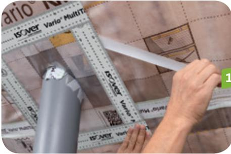
**11** Verkleben Sie den Zuschnitt an der Folie durch Abziehen der äußeren Split-Liner.
