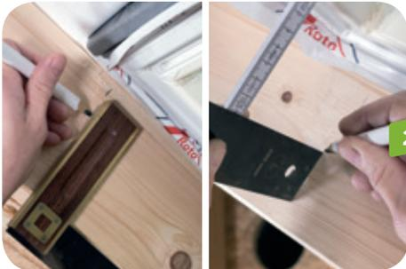
2 Mittels Winkel das Maß aus (1.) winkelrecht zum Sparren verlängern. Entsprechend der Angaben des Fensterherstellers Eckpunkte für den späteren Übergang zu Sturz/Brüstung anzeichnen – hier als Beispiel bei 8 cm, gemessen aus der Innenfutternut des Blendrahmens heraus.
