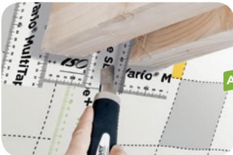
Dann die langen Seiten wie oben beschrieben mit Vario® MultiTape SL+ verkleben. Alle Klebebänder mit einer Anpressrolle / Rakel anrollen.
