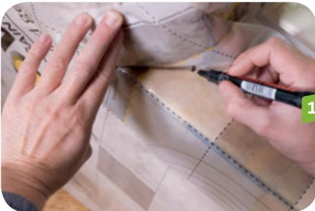
Klimamembran faltenfrei in die Laibung einschlagen und erneut eine Markierung am Ende der Waagerechten setzen.
