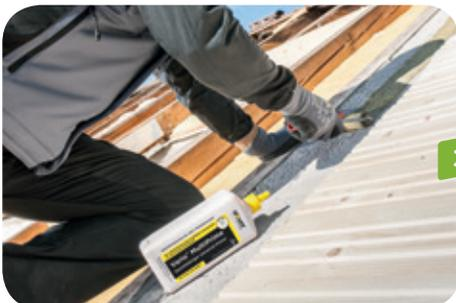
**Tipp:** Durch die gelbe Einfärbung werden bereits behandelte Flächen gekennzeichnet. Die rechteckige Form sorgt auch bei Schrägen für Standsicherheit.
