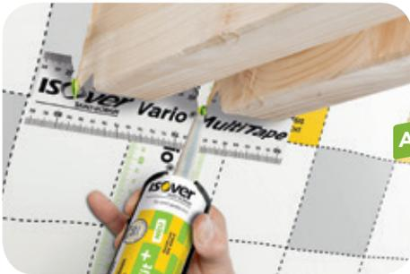
An alle Balkenkanten etwas Klebe-Dichtmasse Vario® DoubleFit+ spritzen.
