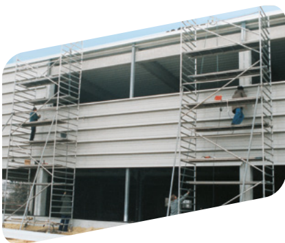
Leere Stahlkassetten vor der Dämmstoffverlegung
