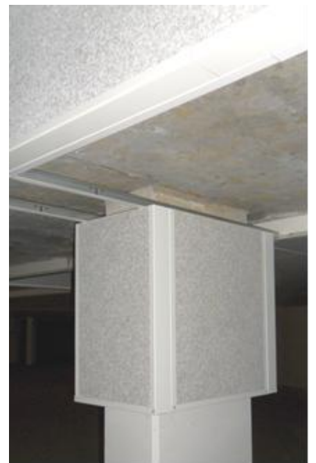
Stütze: DP 1 Schienenmont.
