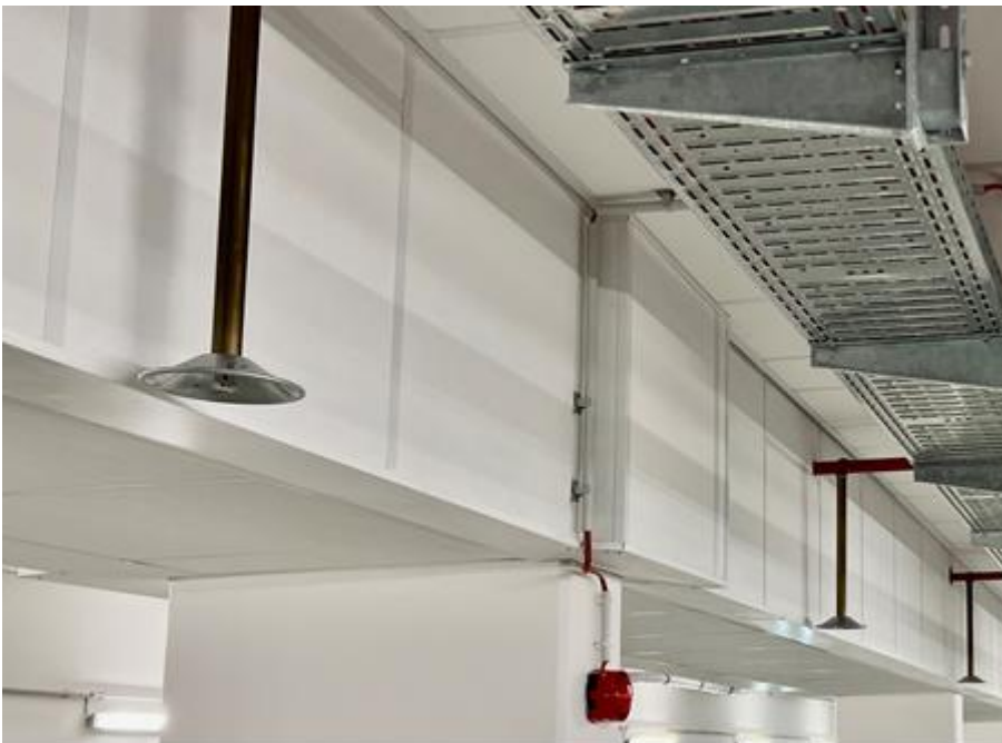
Unterzug: Topdec DP 1 Schienenmontage
