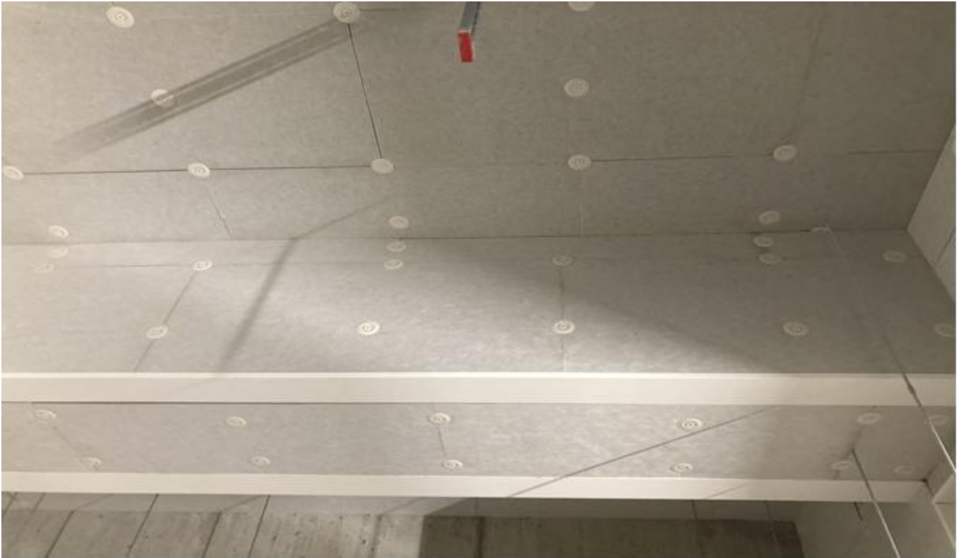
Unterzug: Topdec DP 3 gedübelt mit Kantenabdeckung
