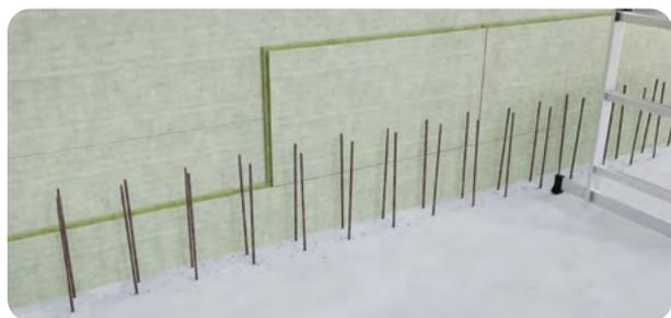
Die **zweilagige Verlegung** mit horizontal und vertikal versetzten Fugen ist ideal für einen sehr guten Luftschallschutz zwischen den Gebäuden.
