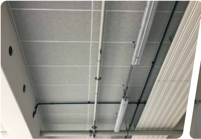
Topdec DP 1, struktur, Schienensystem
