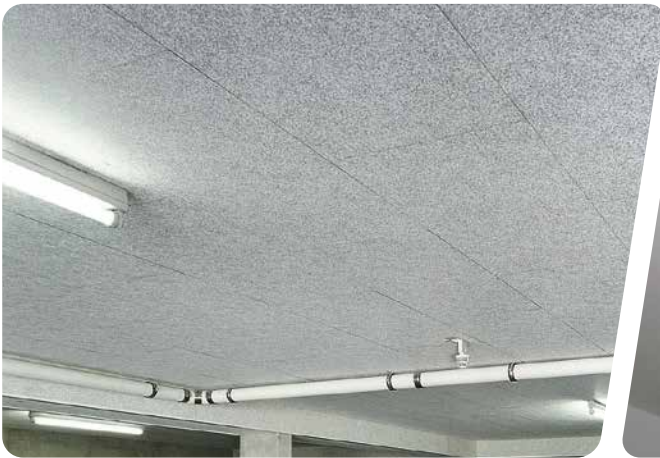
Topdec DP 1 struktur, geklebt
