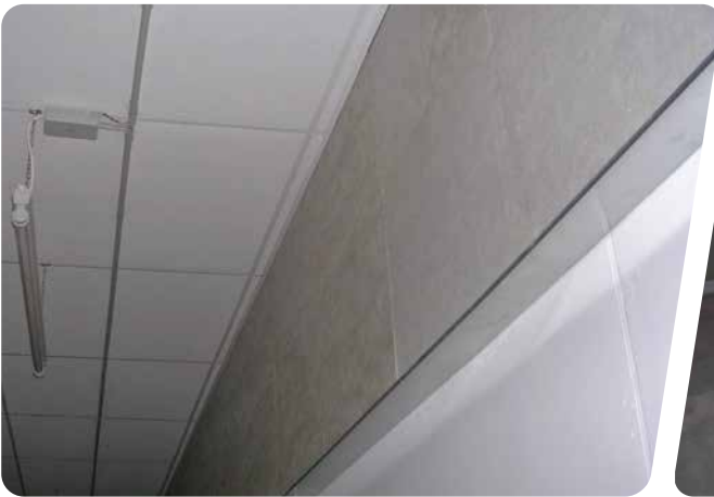
Decke: Topdec DP 1 weiß, Schiene · Wand: Topdec Hardline, geklebt
