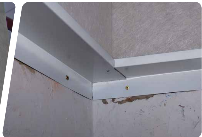
Wand: Topdec DP 3, geklebt, mit Abschlussprofil
