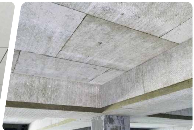
Topdec Universal, geklebt, unbehandelt
