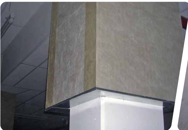
Stütze: Topdec Hardline, geklebt
