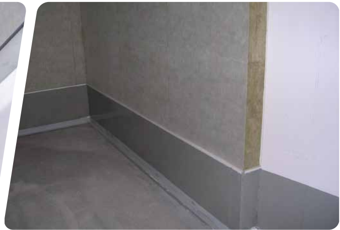
Wand: Topdec Hardline, geklebt
