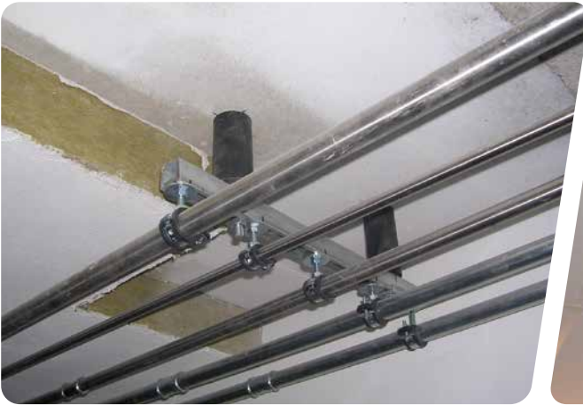
Decke: Topdec Universal, geklebt + gedübelt, gespachtelt
