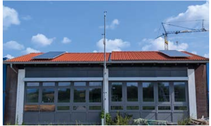
Abbildung 1: Testgebäude im Fraunhofer Institut für Bauphysik in Holzkirchen zur Untersuchung des Einflusses von PV-Anlagen bei unterschiedlichen Dachkonstruktionen.
