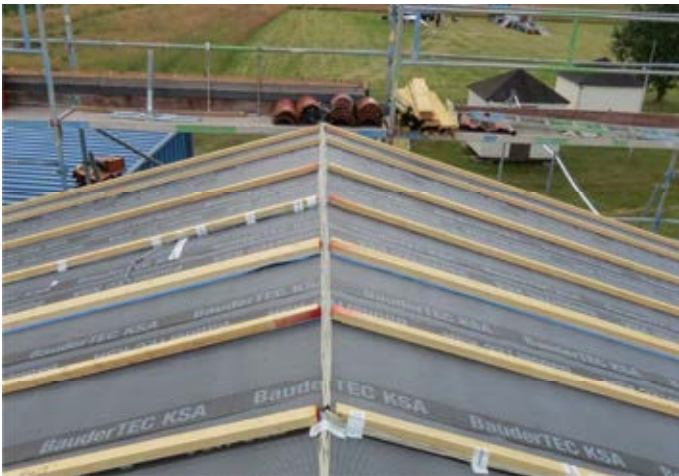
Abbildung 3: Varianten während des Versuchsaufbaus 2023. Links: Variante A mit fertig verlegter diffusions-sperrender Unterdachbahn, Konterlatung und Temperaturfühlern. Rechts: Variante B: Verlegung der Vario KM Supraplex – SKS auf der Holzschalung, rechte Dachhälfte: fertig verlegte Aufsparrendämmung mit aufkaschierter Unterdeckbahn ULTIMATE AP SupraPlus.
