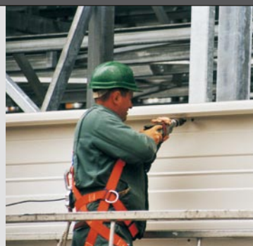
Montage der Metallkassetten-Wandprofile.
