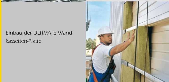
Einbau der ULTIMATE Wandkassetten-Platte und Montage der Außenschale.
