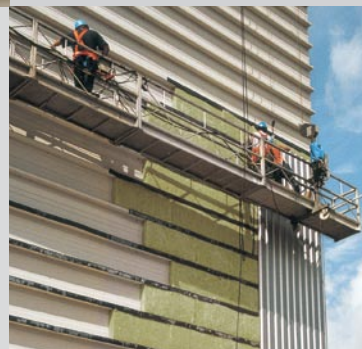
Einbau der ULTIMATE Wandkassetten-Platte und Montage der Außenschale.
