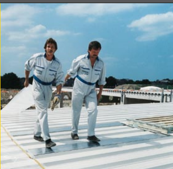
Verlegung der Dampfbremse.
