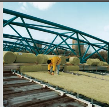
Einbau der ersten Lage ULTIMATE Universal-Filz.
